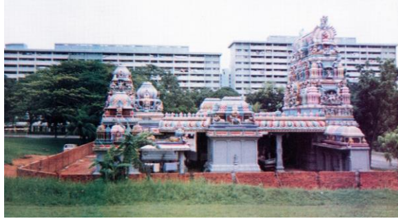
西法克萨那庙刚竣工时的面貌，1996年 西法克萨那庙提供
