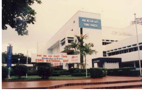
அங் மோ கியோ ஈஸ்ட் நகர மன்றத்தின் அலுவலகக் கட்டடம், 1988 அங் மோ கியோ நகர மன்றத்திற்கு நன்றி
